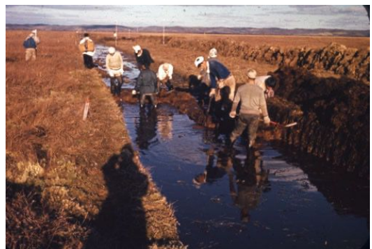
図1. 1961年秋に始まった排水溝掘削。
