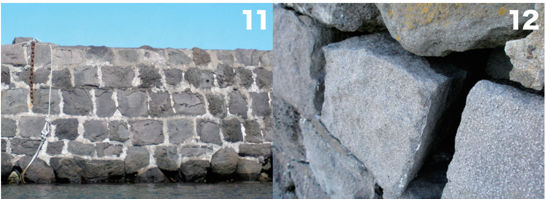
図11 - 12. 11: 堤体の石積み状況, 12: 間知石。
