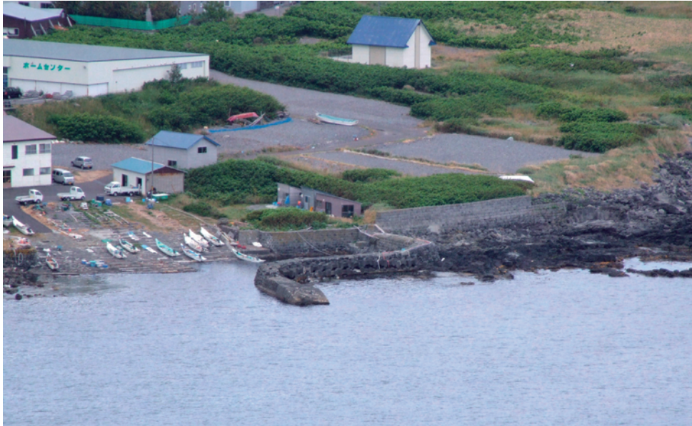
図1. 泉の澗。澗全体（ペン岬頂上から）。
